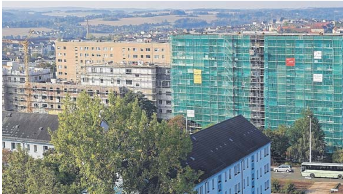
Zwei Großvorhaben nebeneinander: Den Elfgeschoss an der Tischendorfstraße 19-21 (rechts im Bild) saniert die AWG, den Wohnblock an der Tischendorfstraße 23-31 daneben (links) die WBG.
