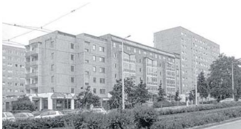
Vor der Sanierung: pure Tristesse. In dem Plattenbau an der Bahnhofstraße gab es trotz günstiger Lage viel Leerstand. FOTOS: ING.-BÜRO EGER BEER & PARTNER (2)
